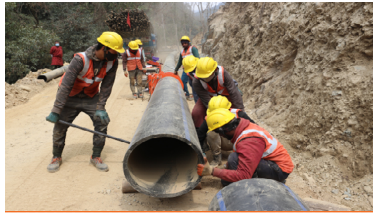
Arbeiter in Bhutan installieren Druckleitungen, die mit neuer und klimaresilienter Technologie nachgerüstet wurden. Das neue Bewässerungssystem wird 24 Dörfer und mehr als 5 km 2 Agrarland versorgen und so der Wasserknappheit in Phangyul entgegenwirken.
